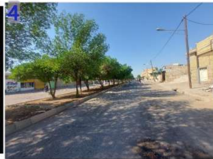
18 متری لوله گاز
